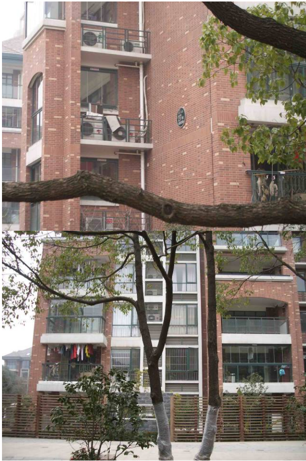
住宅楼，合肥，2007 年——每个房间均采用分体空调来采暖和制冷
